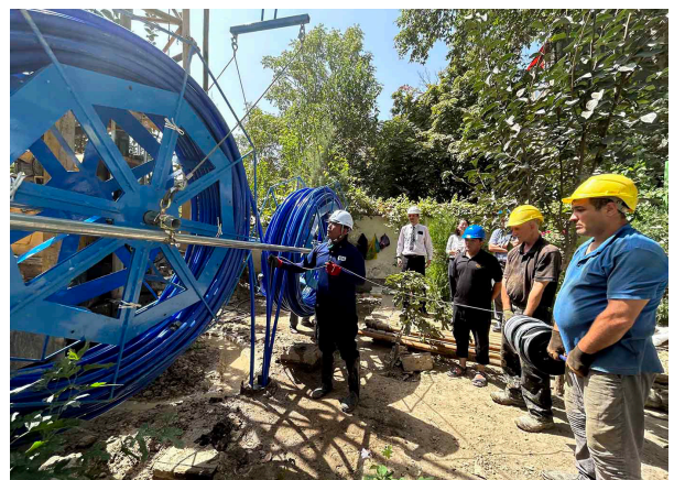
タジキスタン科学アカデミーにおける地中熱交換井設置作業の様子
